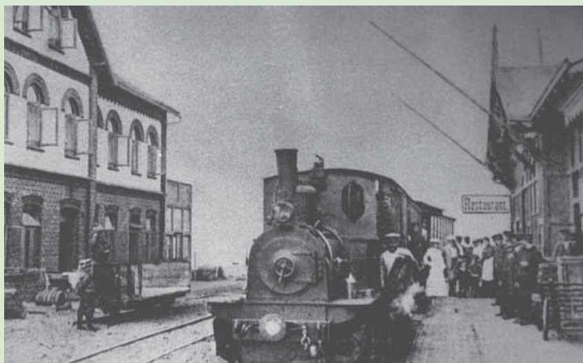
Später wurden die Gleise vom Strand auf die Wittdüner Hauptstraße verlegt. Der Bahnhof bestand hauptsächlich aus dem Fahrkartenraum in dem Geschäftshaus auf der rechten Seite
