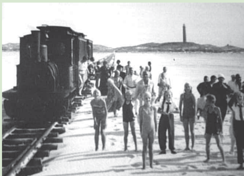
Die Kniepsandbahn auf ihrer aufgeständerten Strecke, die 1909 nördlich des Leuchtturms in die schützenden Dünentäler hineingebaut wurde und dort auf die alte Strecke Wittdün - Nebel stieß. So konnte wenigstens ein Teil der Gleise dem Zugriff der regelmäßig wiederkehrenden Sturmfluten entzogen werden.
